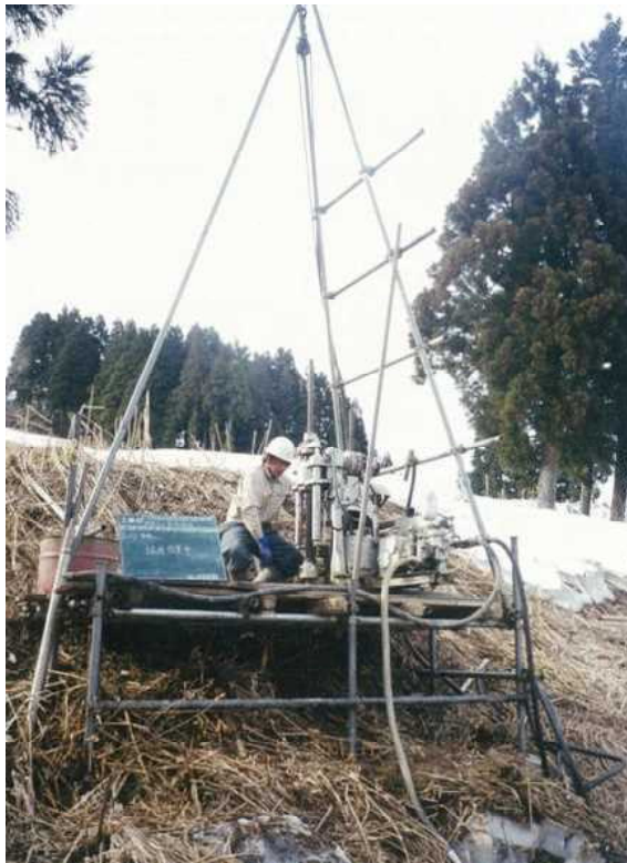
地すべり発生箇所での地中の状況を確認するためのボーリング作業
