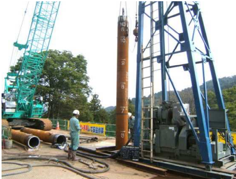
相当な太さの鋼管を用いた杭を打ち込むこともある
