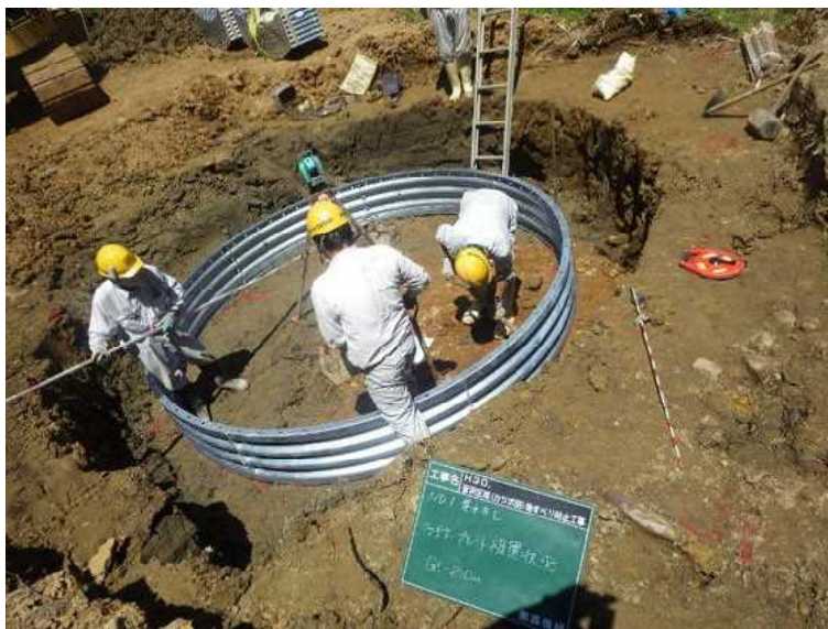
井戸の型となる金属製のプレートを設置して、内側を掘削していく
