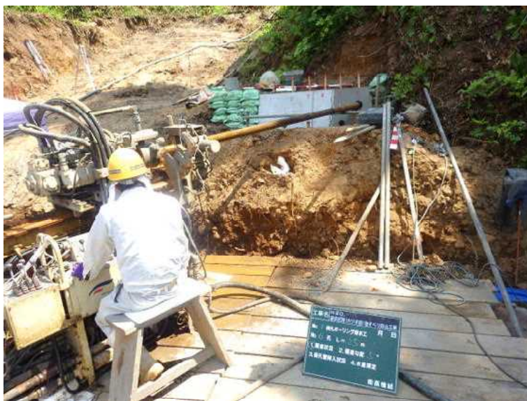
地すべり箇所の斜面に直接横向きに穴を開けていく
