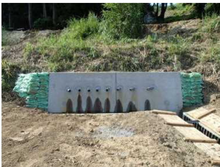
数十メートルもの長さに差し込まれたパイプを通して地下水を抜いていく
