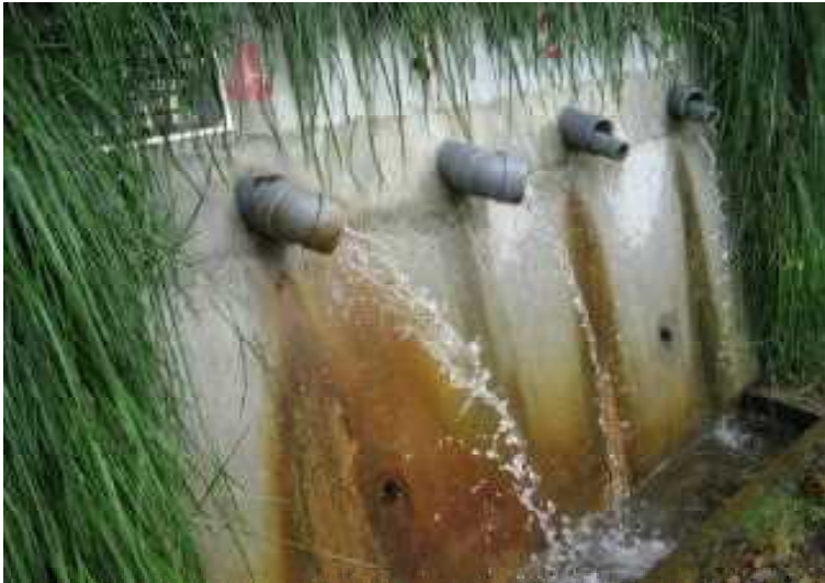
融雪期には地下に浸透した水が大量に流れ出てくる
