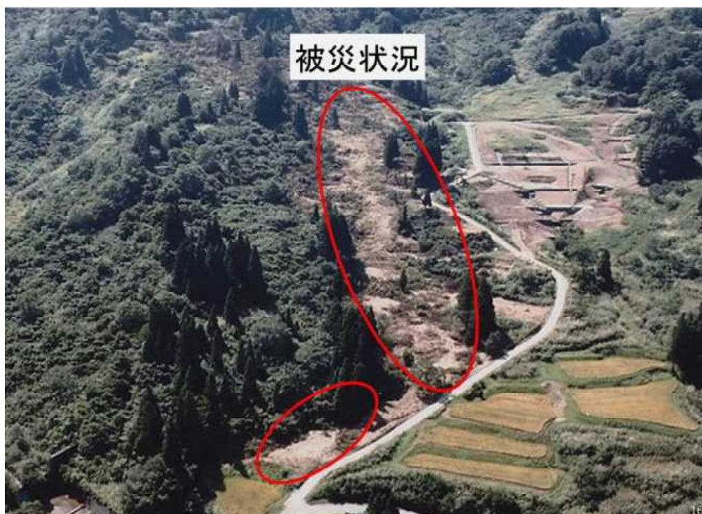
地すべり発生直後の状況（赤い丸印で示した地すべりによる土の塊は、道路や農地にまで迫っている）
