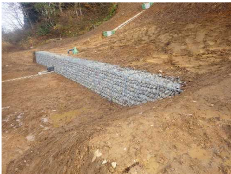
鉄線でもって組んだ籠へ石詰めした土留めを、斜面下端に設置
