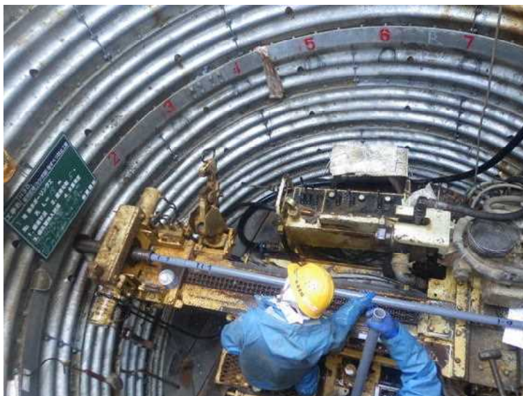
井戸を掘削したら横に向けて細いパイプを入れていく
