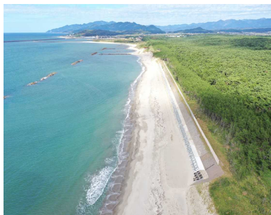
お幕場海岸の防災林造成工事
