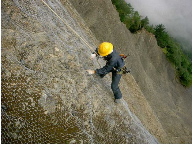
山伏崩 (ラス張工施工中) ※ラス：菱形金網等
