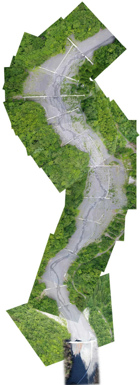
東河内(床固工群)
