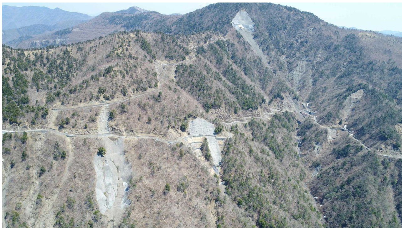
事業実施中の箇所の遠望（小河内工区）
