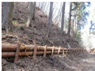
丸太筋工 (斜面からの土砂等の流出を防止)
