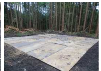
土場の作設 (天地返しと敷鉄板敷設により空間線量が低減)
