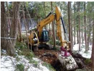
森林作業道の作設 (天地返しと木質チップ散布により空間線量が低減)
