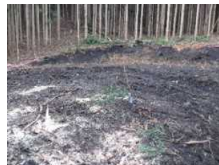
土場の作設 (天地返しと敷鉄板敷設により空間線量が低減)
