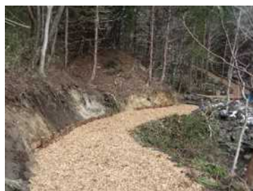
森林作業道被覆工(木材チップ) (重機走行による表層の露出、攪乱を抑制)
