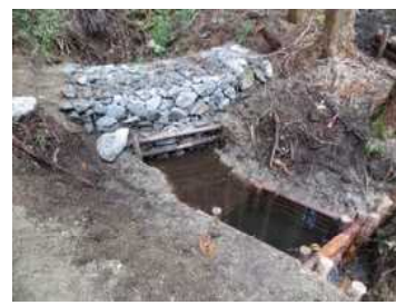
ふとん籠工 (溪流への土砂流出を防止)
