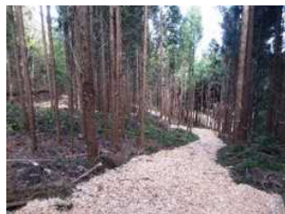
森林作業道の作設 (天地返しと木質チップ散布により空間線量が低減)
