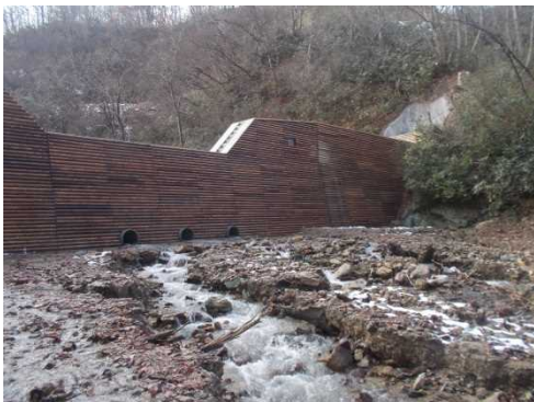
写真4 平成 29 年度施工の谷止工
