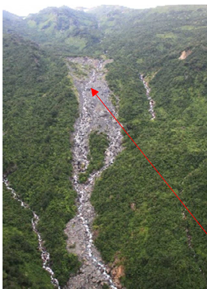
写真2：山腹崩壊の状況
