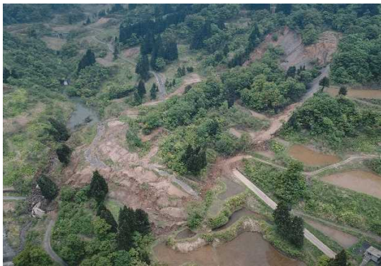
写真 6：上越市安塚区での地すべり災害 （2000年（平成12年）5月）
