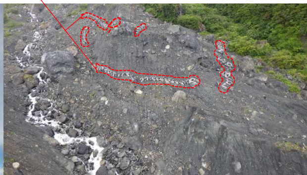
写真4：「袋型石詰筋工」の施工状況
