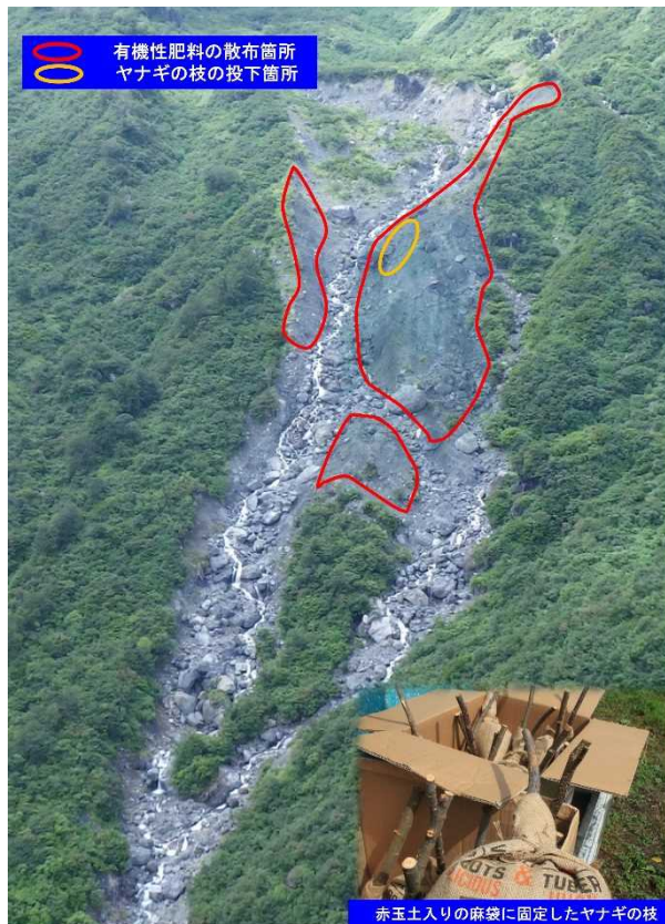
写真5：緑化工の施工状況
