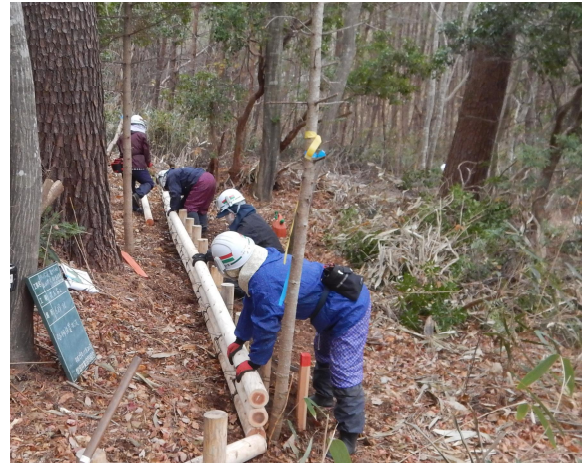
木の柵の設置
