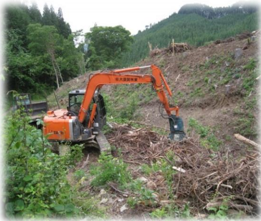
一貫作業システムによる地拵の様子
