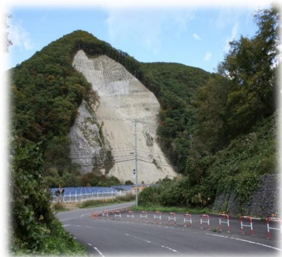
戸倉山治山工事（天栄村）
