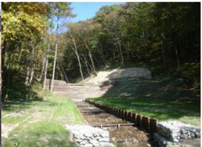
間伐材を利用した水路工
