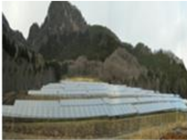
メガソーラー発電施設
