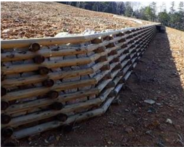
間伐材を利用した土留工
