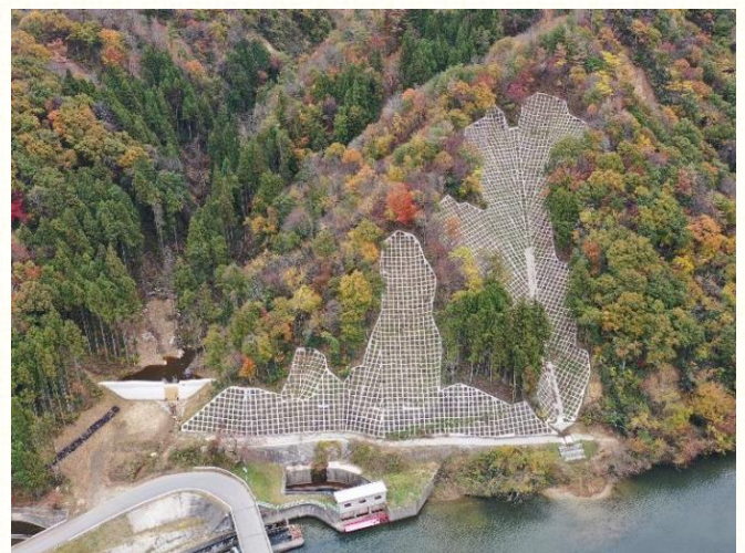
薬師岳地区災害関連緊急治山工事
