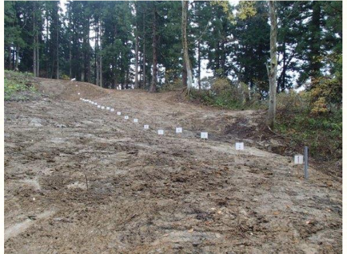
上牧区域（A-1）直轄地すべり防止工事
