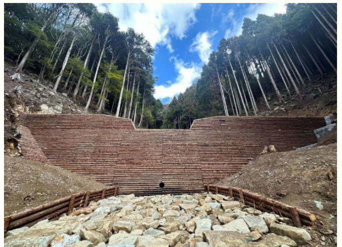
荻野入地区復旧治山工事
