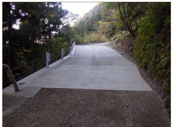
本谷（本谷）林道災害復旧工事
