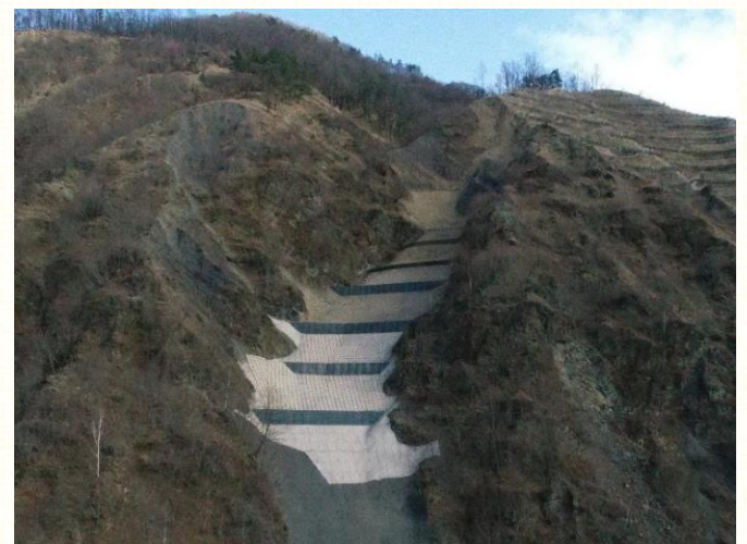
下桐久保沢地区（下桐久保沢）復旧治山工事（R4補正）
