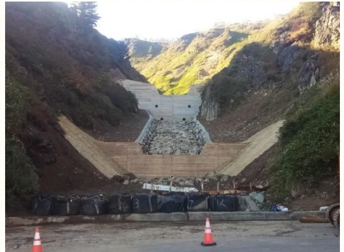
白根地区地域防災対策総合治山工事（R4補正）
