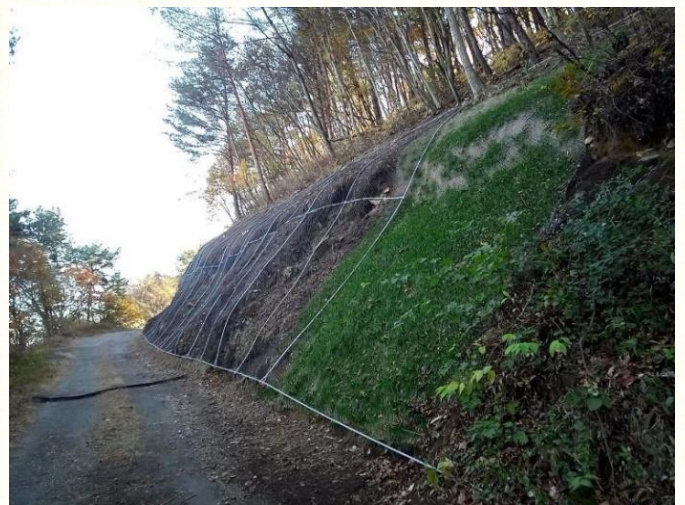
赤岩林業専用道改良工事（R4補正）
