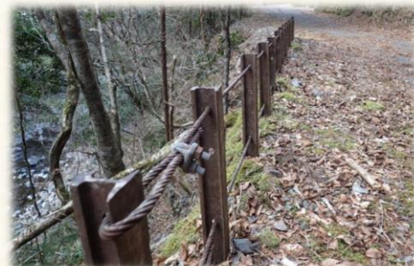
森林鉄道レールを利用したガードレール
