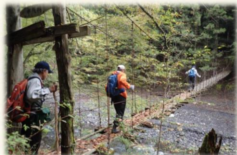
現役の吊り橋
