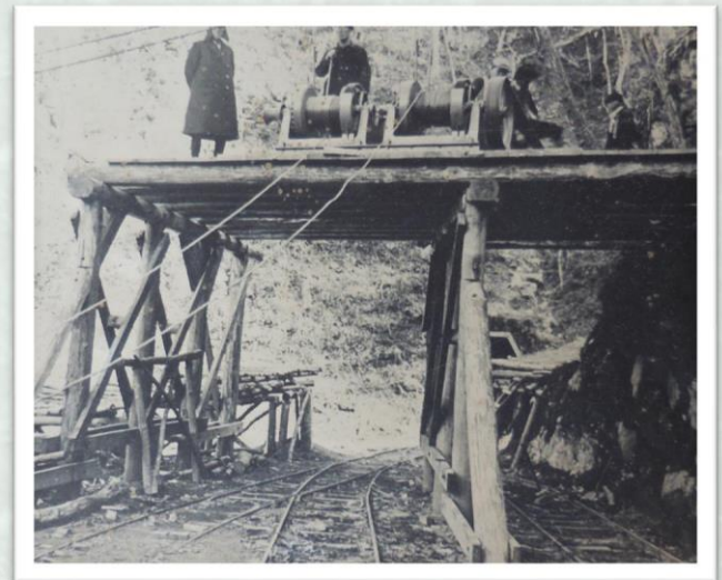
浜通りでの索道による集材 (昭和23・24年頃)
