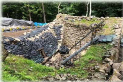
修復中の国指定重要文化財 東谷（あずまや）風穴
