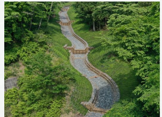
奥の沢川1 令和5年度完成工事
