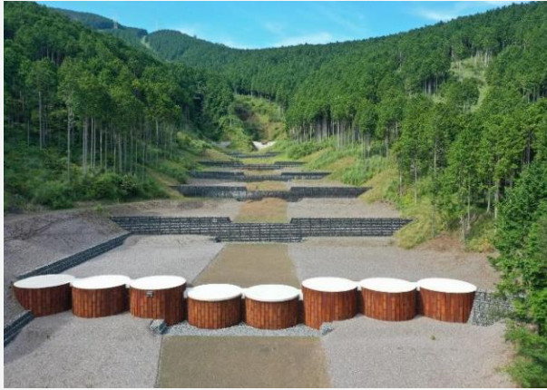
現地発生土を使用した鋼製セルダム
