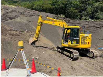
ICT建設機械による掘削
