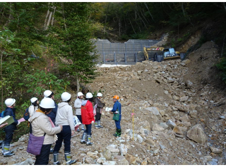
関東・東北豪雨災害からの復旧工事現場を視察
