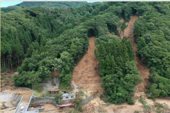
災害発生直後 新潟県村上市薬師岳地区
