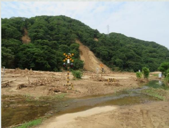
土砂に埋まった JR 米坂線 (新潟県村上市貝附地区)
