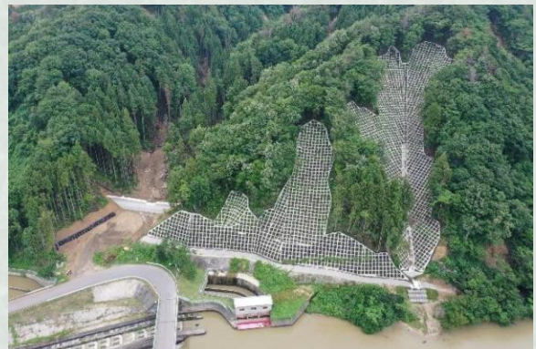
復旧対策工事後 新潟県村上市薬師岳地区
