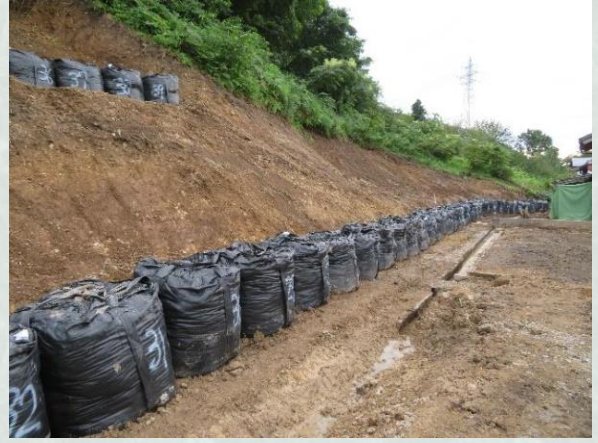
応急対策工事实施後 新潟県村上市花立地区
