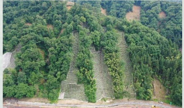
復旧対策工事後 新潟県村上市貝附地区
