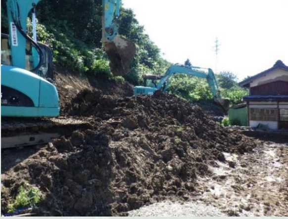
応急対策工事实施中 新潟県村上市花立地区
