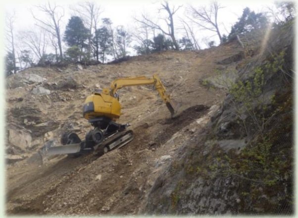
法面上部のアンカー（主に立木）とワイヤー でつなぎ、安全を確保しながら工事を行う RCM（ロッククライミングマシン）
