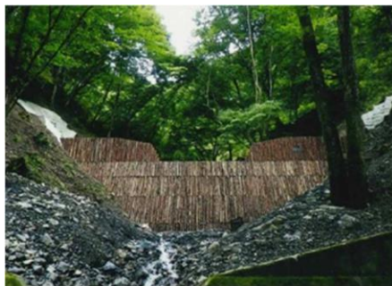
木製残存型枠を使用したコンクリート谷止工
