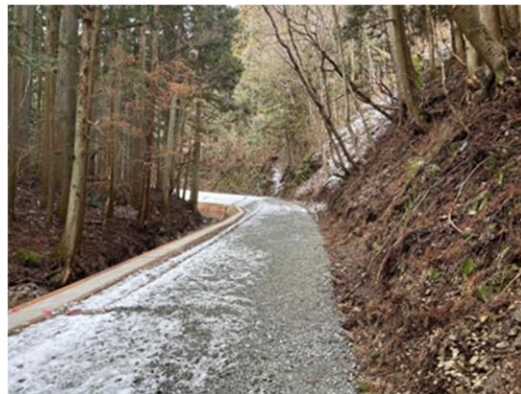
令和5年度に実施した大富林道改良工事（南相馬市）
