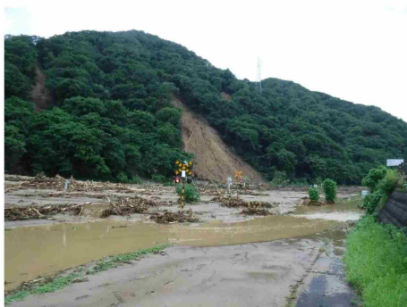
被災状況（村上市貝附地区）
