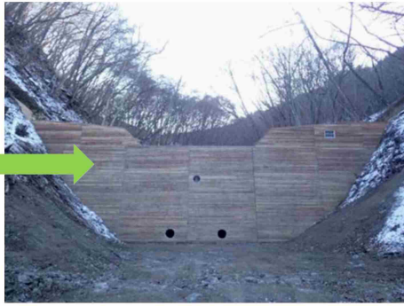
令和3年度施工のコンクリート谷止工
