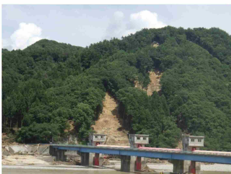
被災状況（村上市薬師岳地区）
