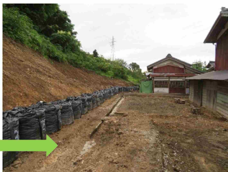
応急復旧完了（土砂撤去・大型土のう）
