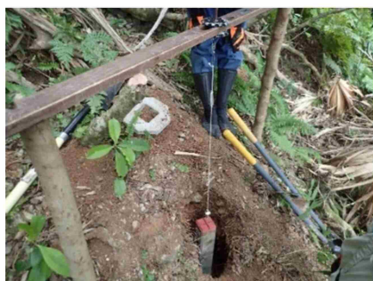
▲ 境界標の埋設作業
