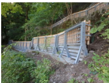
緩衝材に間伐材を利用した 落石防護柵
