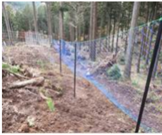
低コストで設置できる 斜め張りネット
