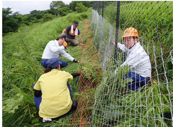
アンカーの打込作業
