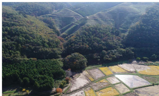
【台風19号による被害状況】
