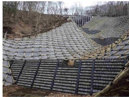
▲ 山腹工（土留工・法枠工）
