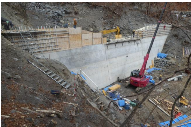
治山ダム施工中
