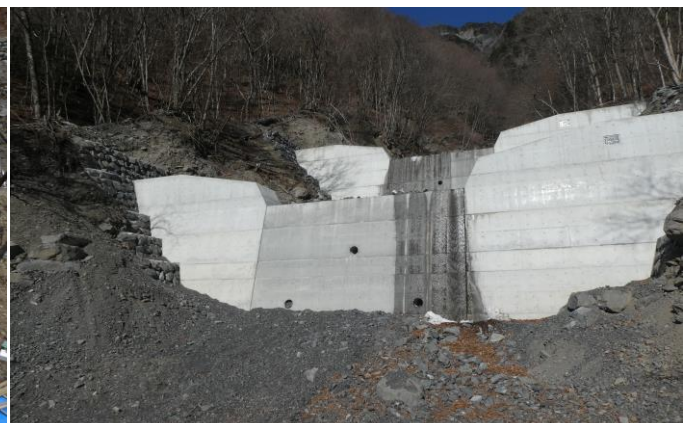
治山ダム竣工
