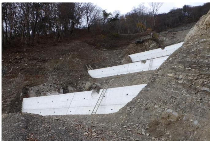
土留工（コンクリート）
