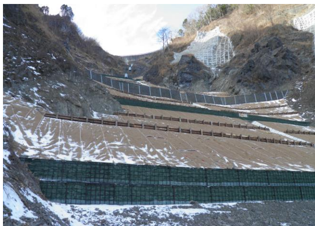
土留工（鋼製枠）
