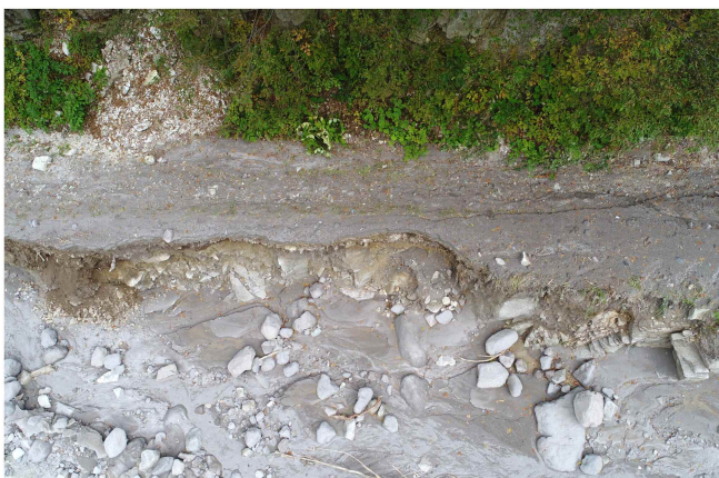
被災した林道（ドローンによる上空からの撮影）
