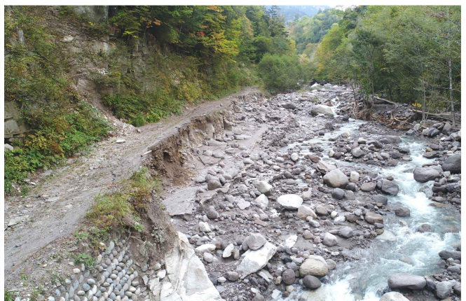
被災した林道（地上より撮影）
