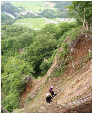
大戸地区 治山工事現場
