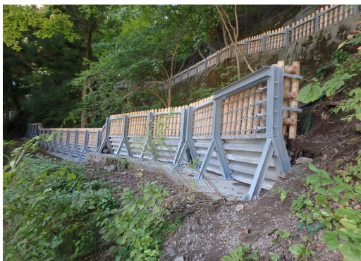
元湯地区復旧治山工事 （塩那森林管理署）
