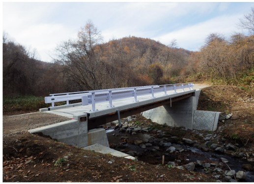
万座林道改良工事 (吾妻森林管理署)
