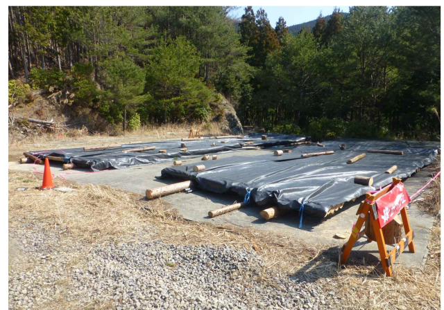
平成31年3月 養生管理
