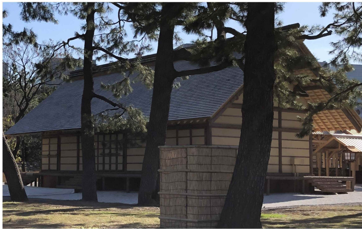
廻立殿の外壁に使用された天竜スギ
