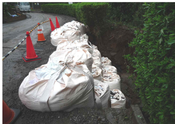
大型土嚢による応急措置
