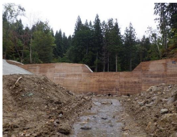
令和3年度完成のコンクリート谷止工（西ノ沢）
