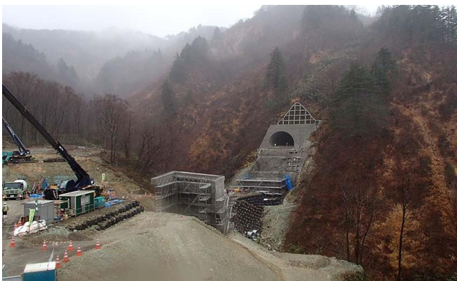
現在工事中の国道289号線 （出典元：長岡国道事務所 HP）
