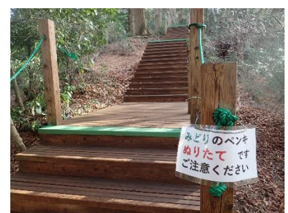
▲ 作業後の状況
