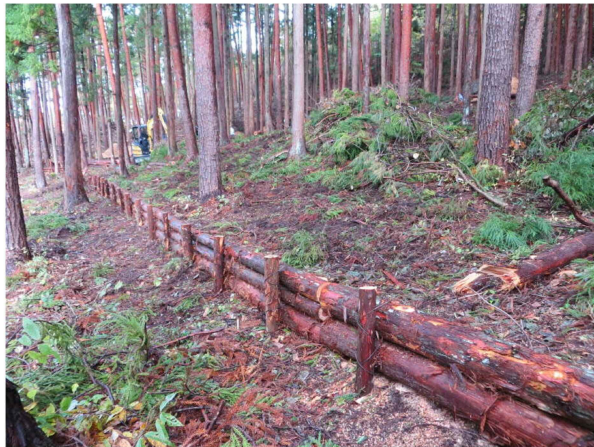
丸太筋工施工後
