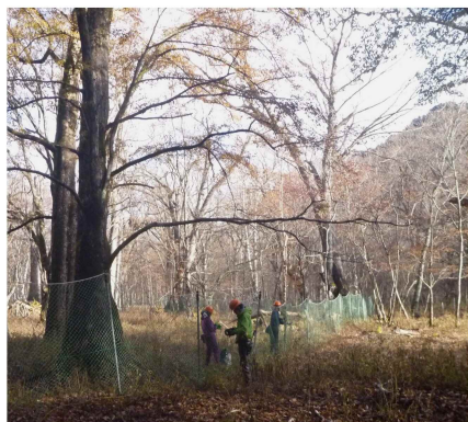
シカ柵修繕作業
