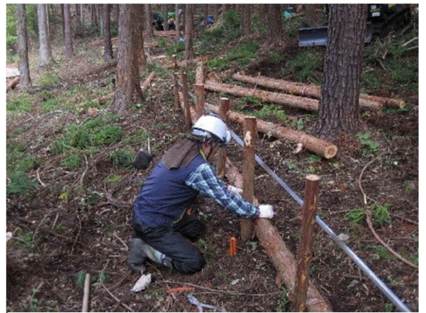
丸太筋工施工中
