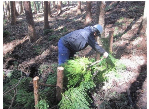
編柵工施工中
