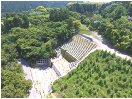
復旧工事完成後
