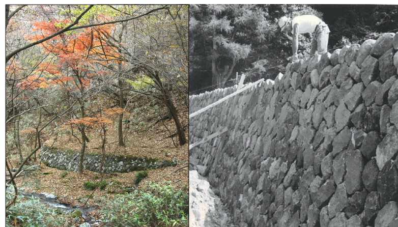
(写真2) 土留工の現在
