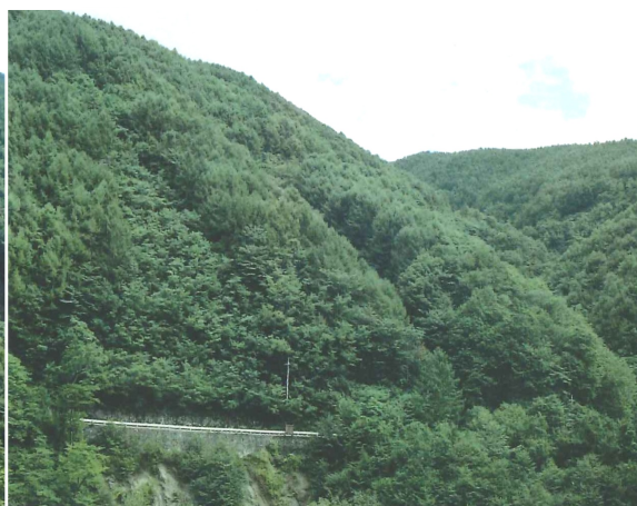
治山工事が終了した山腹（山梨県笛吹川）
