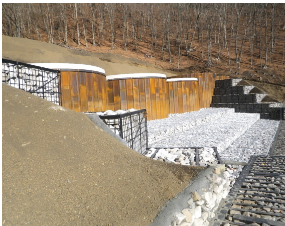
(写真4) セルダム
