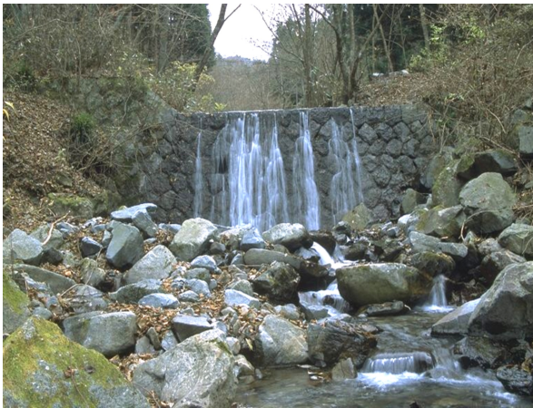
(写真1) 石積の治山ダム
