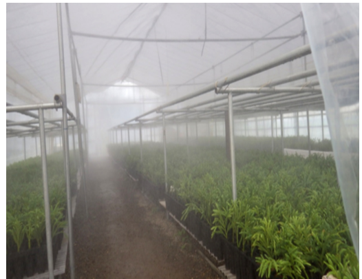
自動散水器により決まった時間に決まった量の散水が可能
