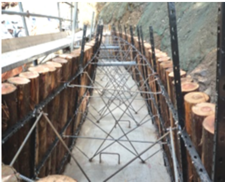
丸太残存型枠組立後 (コンクリート打設前)
