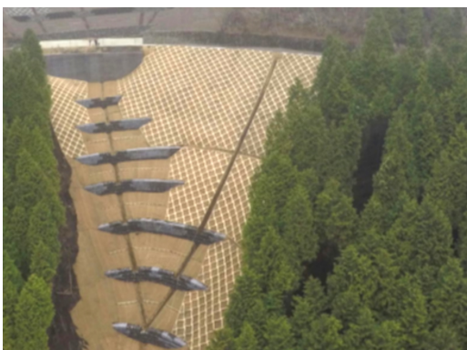
木材を使用した法枠工
