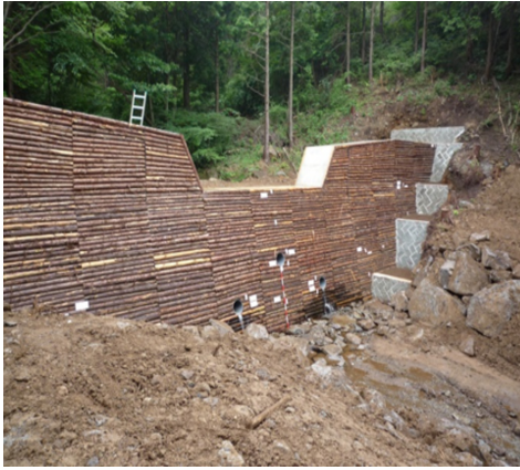
丸太残置型枠を使用した治山ダム
