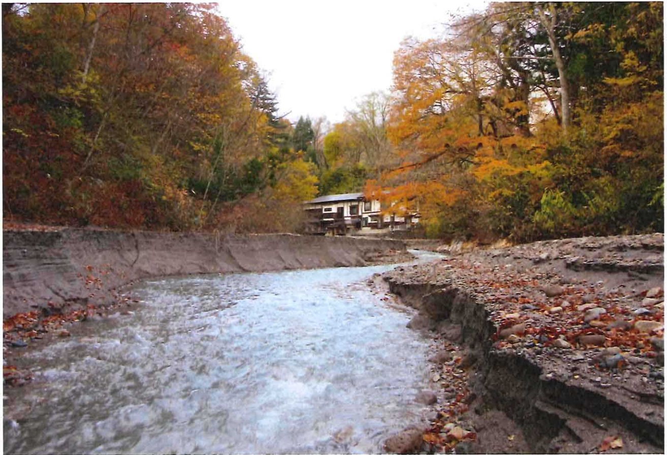
木賊温泉 共同浴場岩風呂 台風19号被災後状況(令和元年11月6日)
