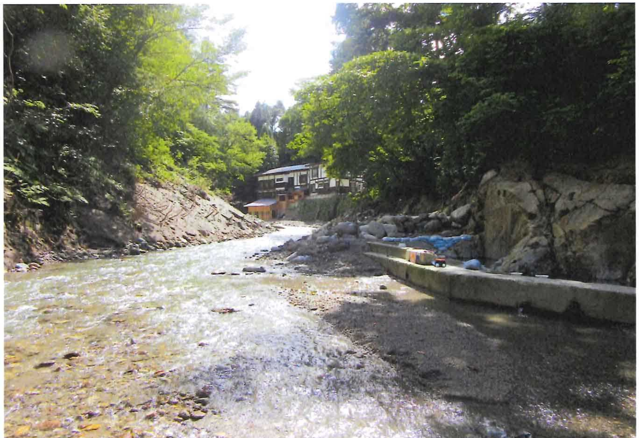
木賊温泉 共同浴場岩風呂 復旧状況(令和2年8月12日)
