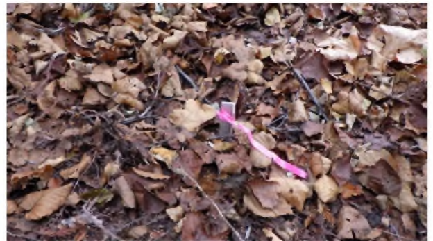
写真 No. 6 L 字杭 (A) 設置状況
