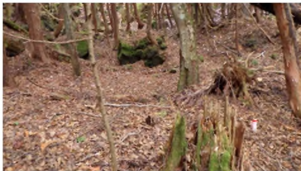
写真 No. 7 L 字杭 (B) 設置状況
