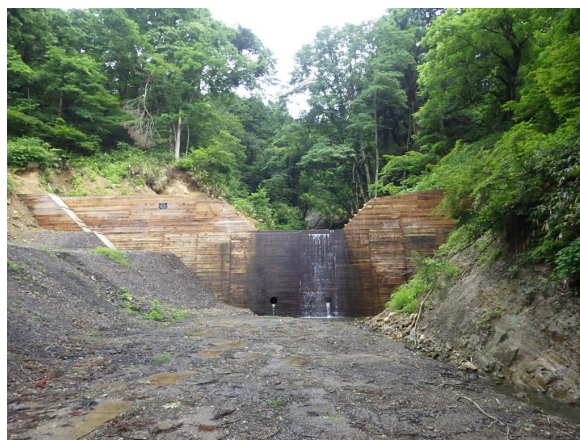
コンクリート谷止工（R5年度竣工）
