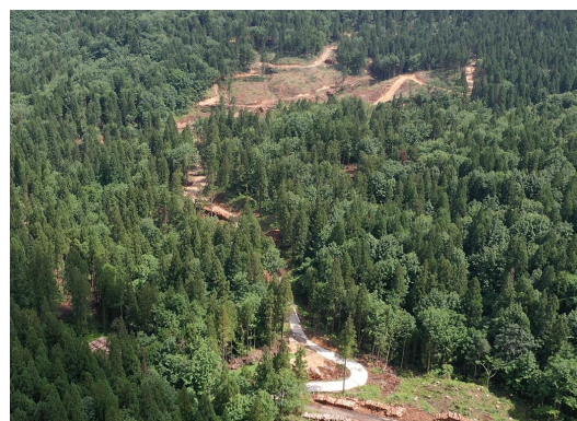
林業専用道（手前）と森林作業道
