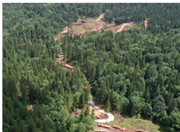
林業専用道（手前）と森林作業道
