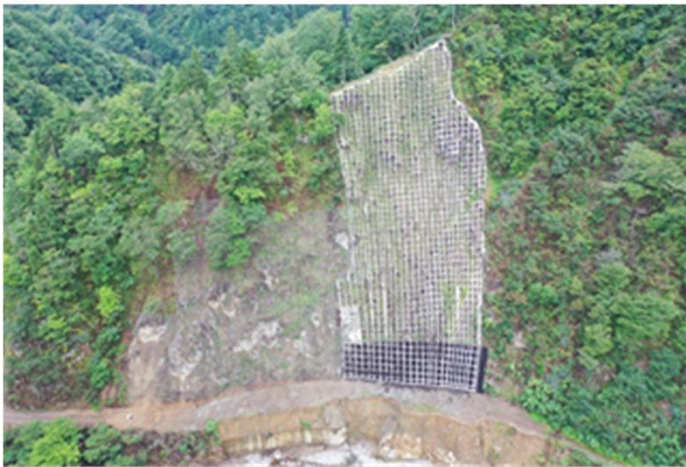
山腹工（R5年度施工）
