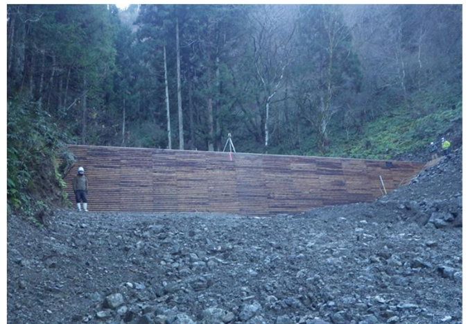
コンクリート谷止工（R7年度竣工）
