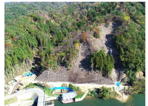
災害関連治山対策施工状況
