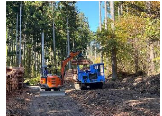
間伐に伴い生産された材の搬出 (北茨城市)
