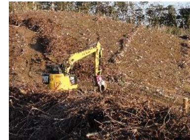
機械地拵実施箇所 （常陸太田市）
