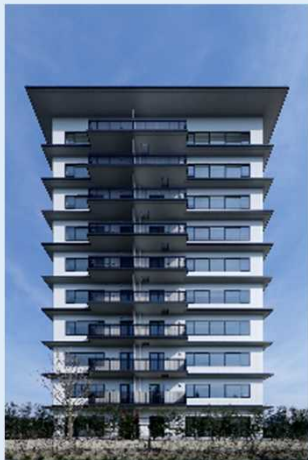
木造と鉄骨造を組み合わせた集合住宅(仙台市)
