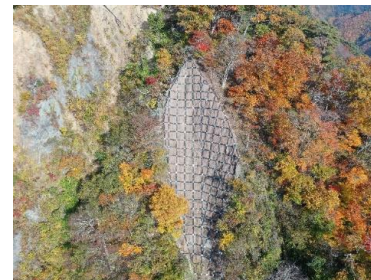
予防治山工事（山腹工）
