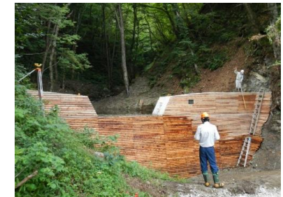
丸太残存型枠を用いた谷止工
