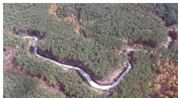
林業専用道の新設
