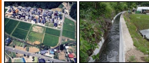
ほ場整備による農業生産性の向上と秩序ある土地利用の推進 老朽化した用水路の整備・更新
