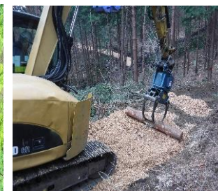
作業道へのチップ散布(チップ均し)
