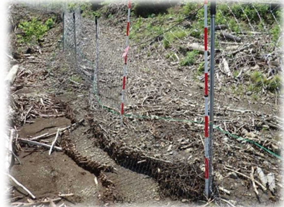
（写真－3）堆積土砂がネットを緊張する様子
