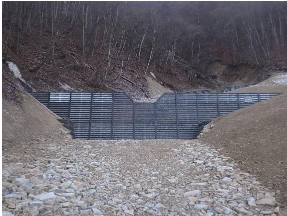
○No. 1 鋼製枠谷止工
