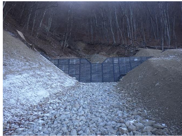
○No. 2 鋼製枠谷止工
