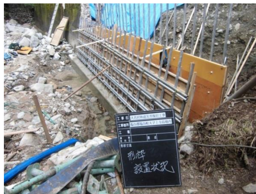
木製型枠を使った擁壁工（塩谷町上寺島）
