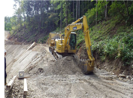
林業専用道新設工事
