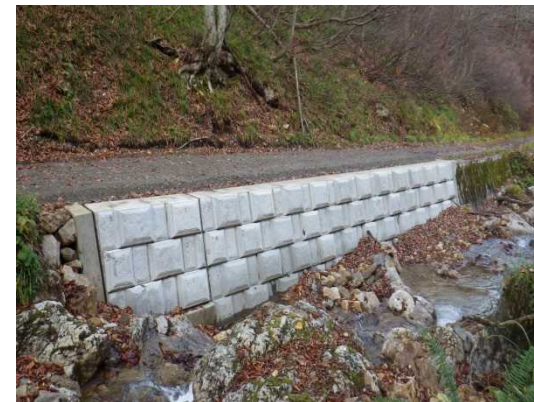
林道改良工事
