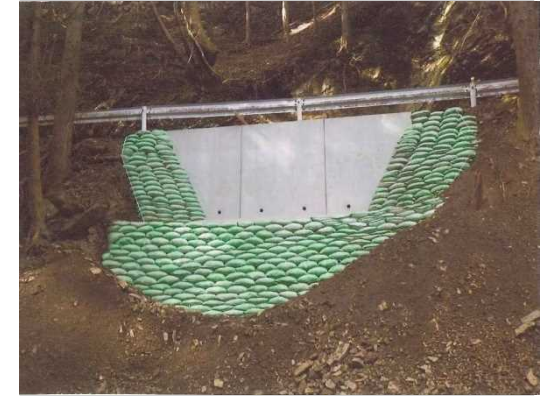
林道改良工事
