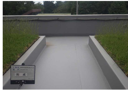
シートによる防水状況
