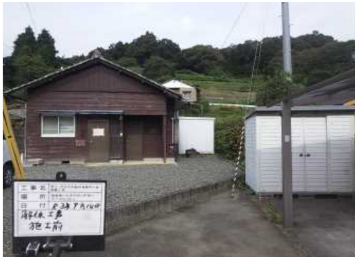
築50年を経過した森林事務所
