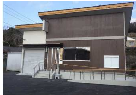
CLTパネル工法で建築された森林事務所
