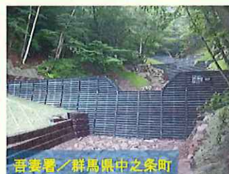
← 溪間工（鋼製枠谷止工）
