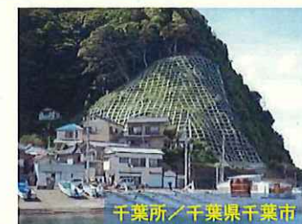
山腹工（法砕工） →
