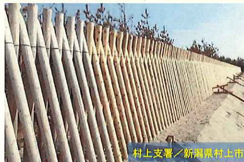
木製の丸太防風柵工
