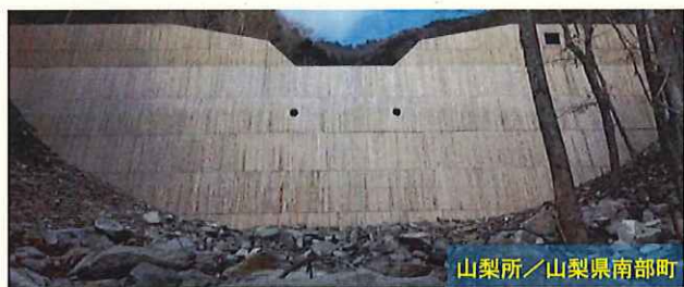
コンクリート構造物の型枠に木製型枠 を使用
