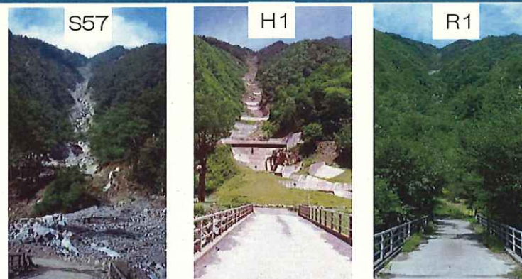
野呂川地区（山梨所：山梨県南アルプス市、韮崎市）
