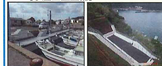
漁業作業の効率化と安全対策のための漁港整備（岸壁改良） 漁村における津波避難対策（避難地、避難路の整備）
