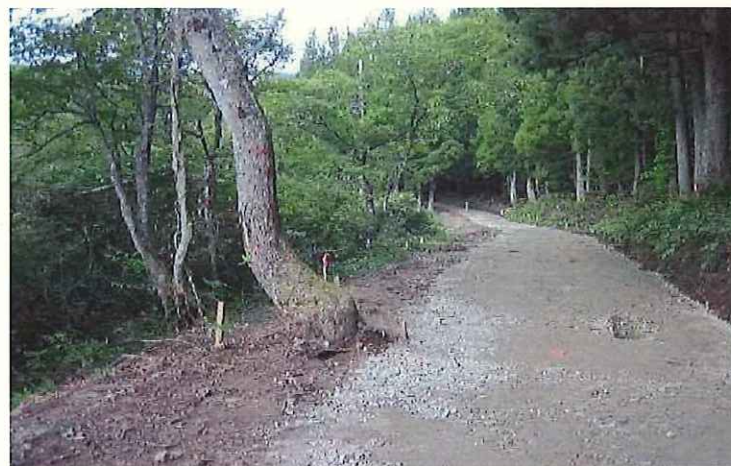
【新設 中の沢林道】
