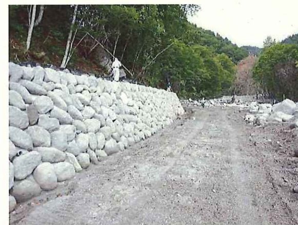
巨石積護岸工：施工後
