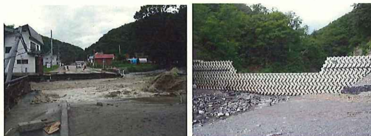
坪入山地区復旧治山工事 コンクリートブロック谷止工
