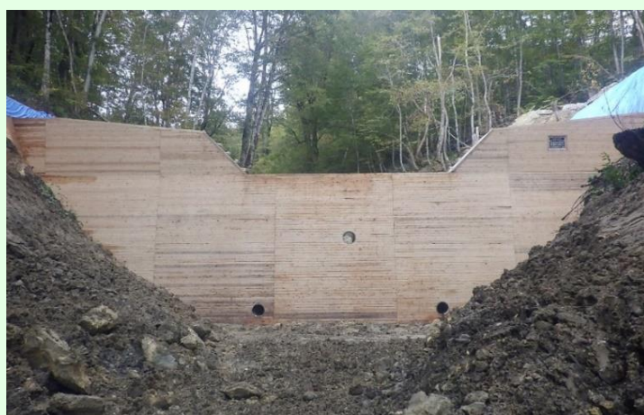
間伐材を利用した治山施設
